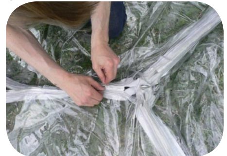
3 ; zuerst wird für die Elementverbindung der Reißverschluss verbunden
