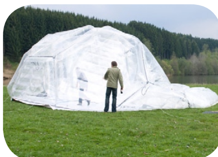
6; über ein elektrisches Gebläse wird die gesamte Konstruktion zentral aufgeblasen. Ohne viel Zutun füllt sich die Konstruktion 2; die Elemente werden zum Verbinden automatisch mit Luft
