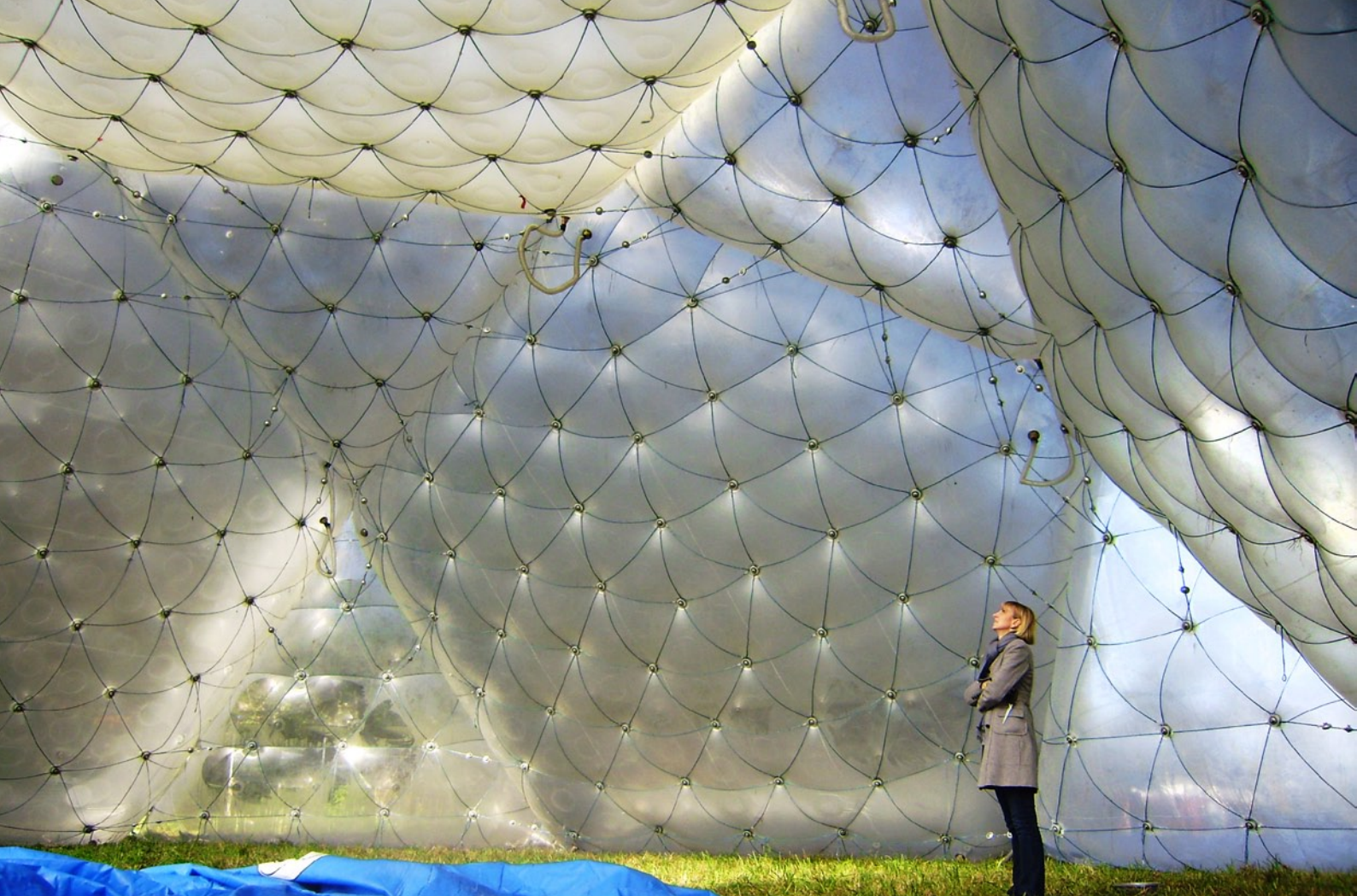
Lichteinfallsteuerung durch reflektierenden Dreieckraster Aufdruck
