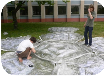
2; die Elemente werden zum Verbinden am Boden positioniert. Für den Aufbau werden weder Gerüste noch ein Kran benötigt
