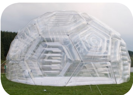
7; sobald der nötige Luftdruck erreicht ist, schaltet sich das Gebläse automatisch aus und schaltet sich erst dann wieder ein, wenn der Luftdruck gefallen ist.
